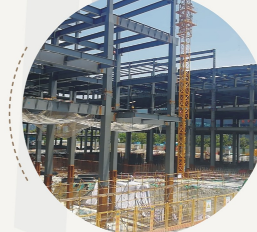
清华研究院项目完成抢修后，按原设计要求恢复施工
