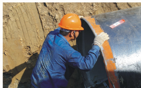
轨道交通6号线迁改现场，工人正在检查管线内部情况
