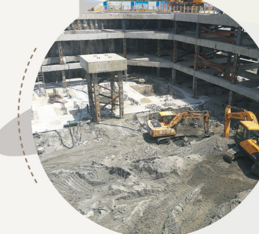
台风过后，狮山广场项目排除现场积水，基坑内恢复施工
