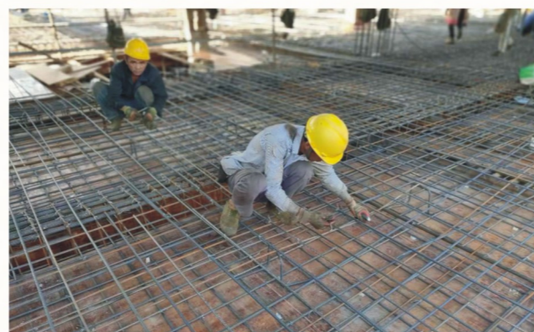
苏州金融商务广场项目，工人正仔细检查每一处钢筋
