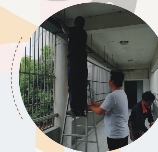
美林公寓集宿区加强排查，对通信、电力设施进行维修加固
