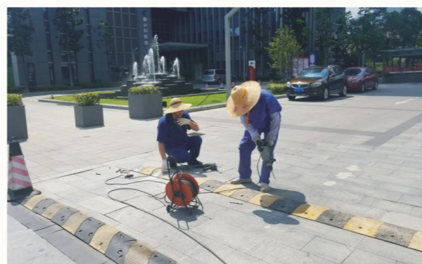
在永新大厦项目，物业工程部正在烈日下维修减速带
